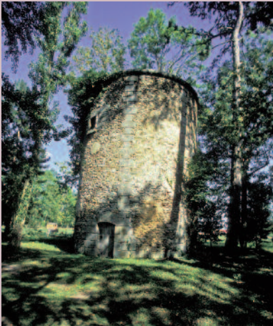
LE PIGEONNIER DE L'ANCIENNE FERME
